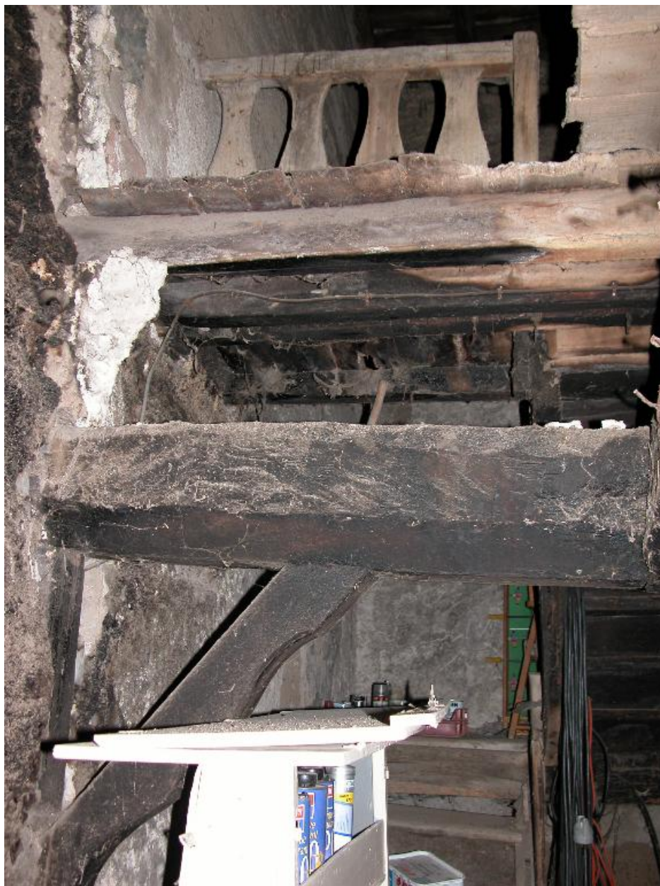
Fournil : vue d'ensemble intérieure
