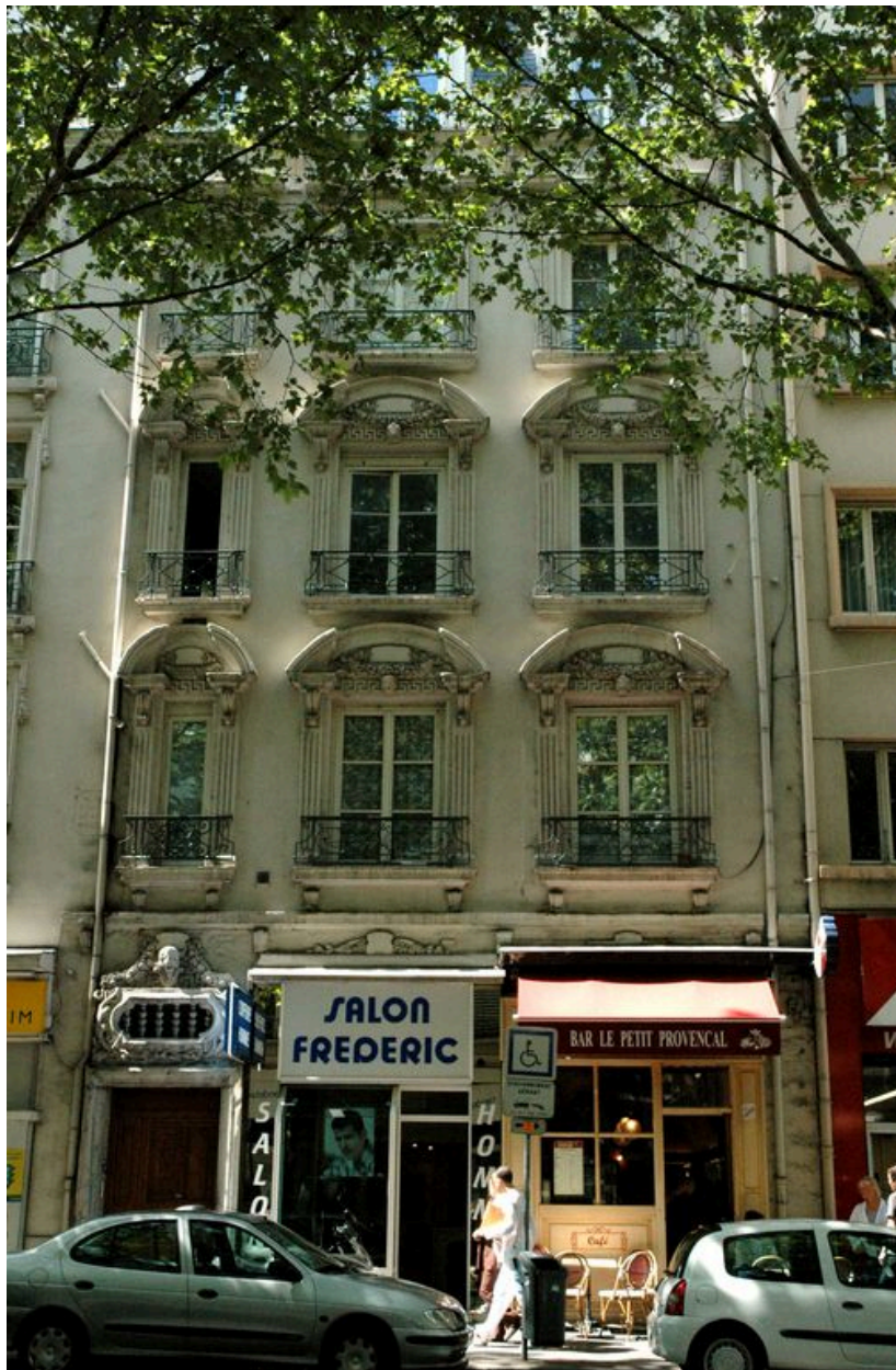
Vue de la partie droite de la façade principale
