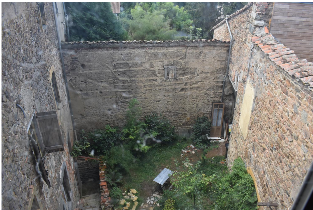
Vue d'ensemble de la cour située au nord de la maison. Vue d'ensemble.
