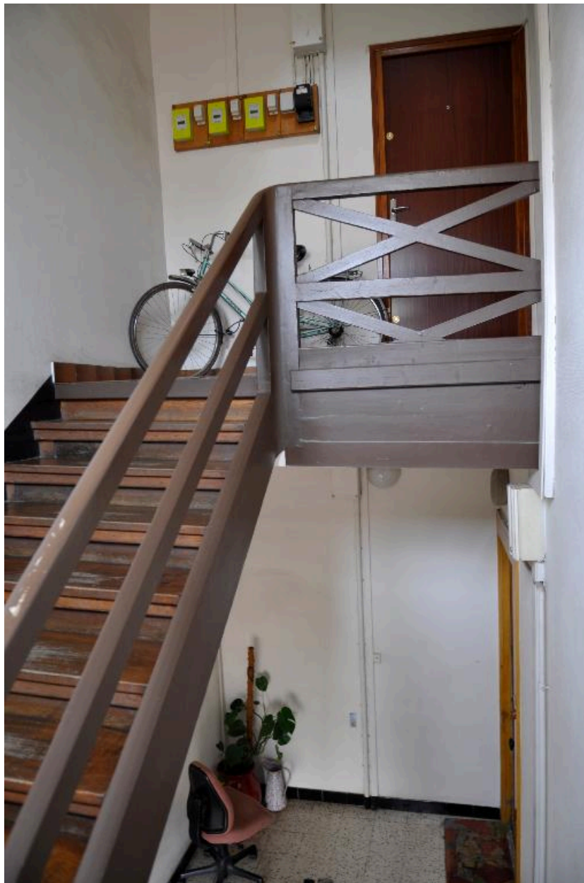
Vue intérieure : la deuxième révolution de l'escalier, en bois
