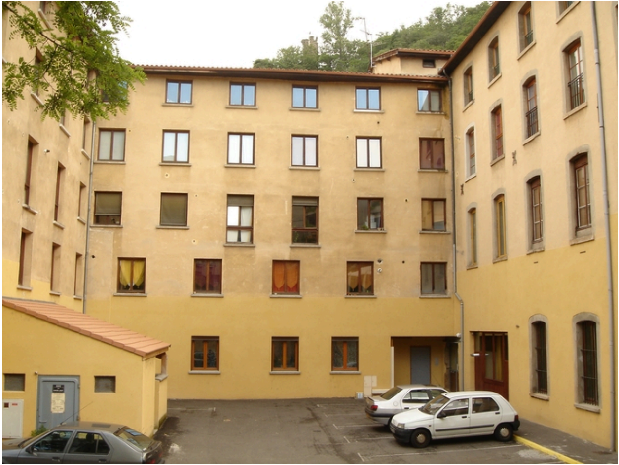
Façades sur cour
