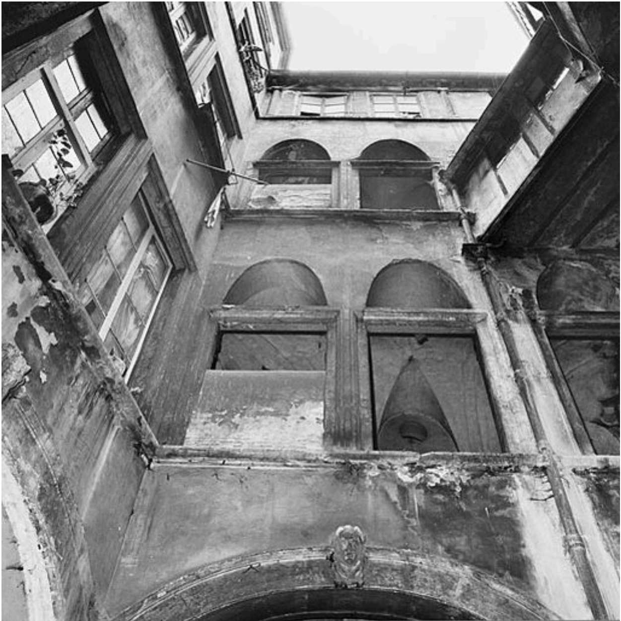
La cour : galerie de circulation desservant les appartements, 1976
