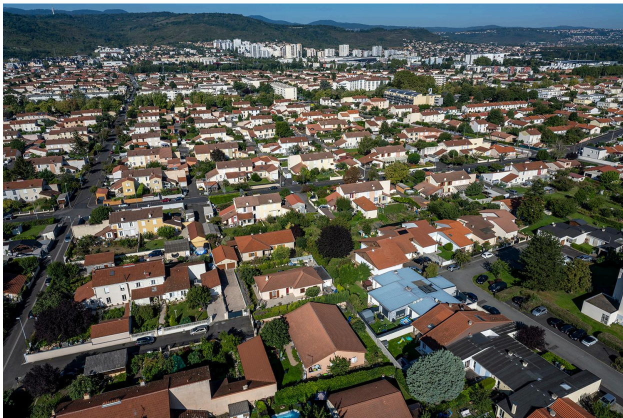
Vue aérienne partielle de la cité en direction de l'ouest.
