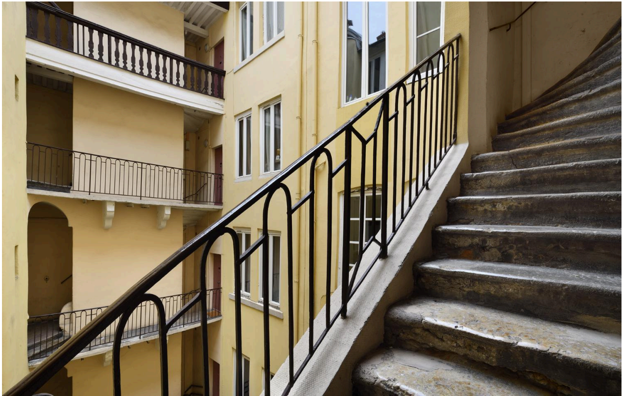
A droite, volée d'escalier. A gauche l'immeuble sis 3 rue Jean-de-Tournes
