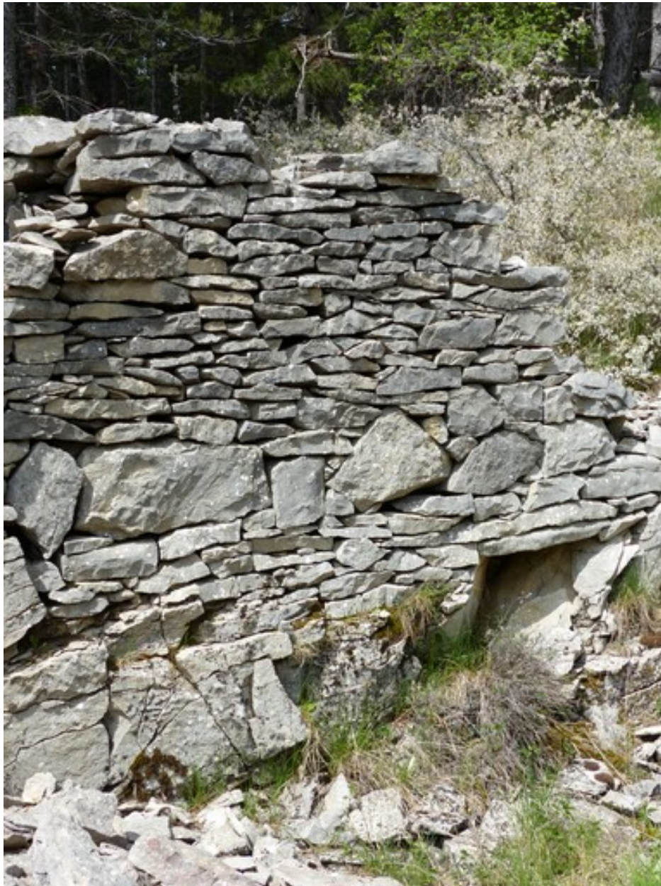
Maçonnerie en pierre sèche d'une bergerie, assise sur le rocher. Quartier des Plaines.
