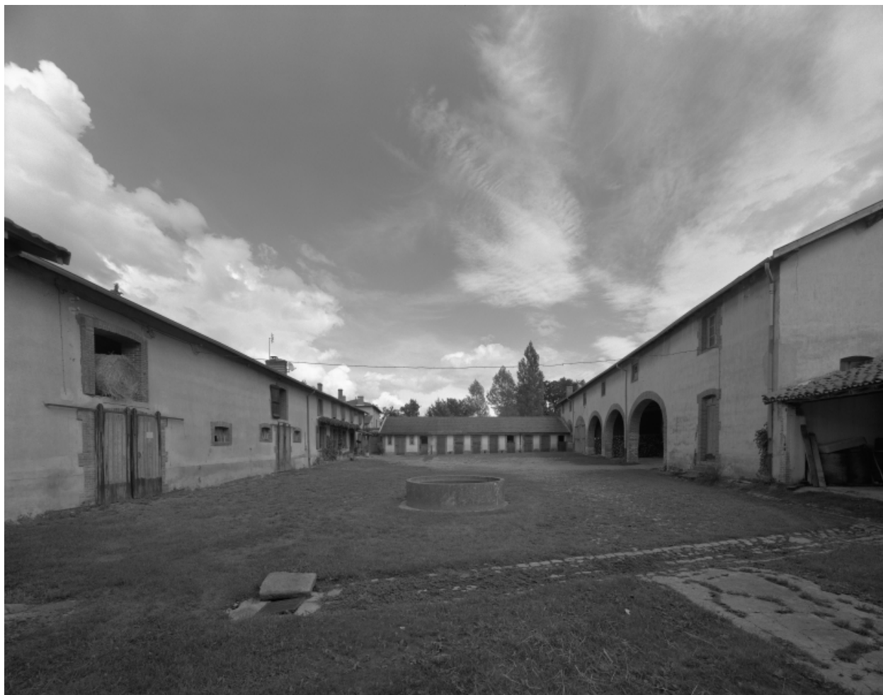
Vue de la cour depuis l'est.
