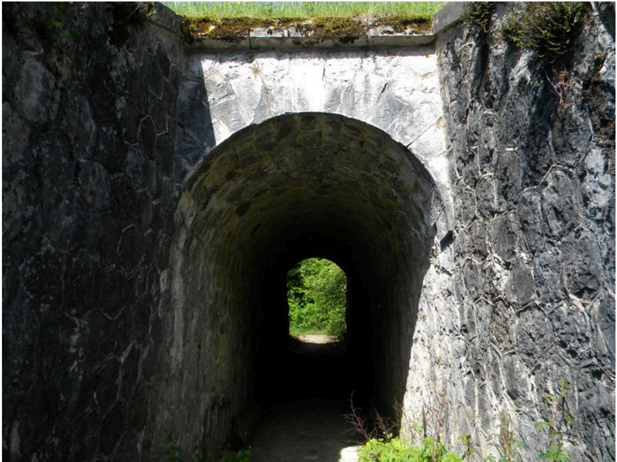
Vue de la voûte en pierre de taille.
