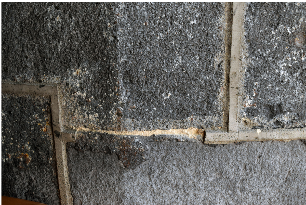
Bâtiment C : ancien réfectoire des pensionnaires, détail des joints saillants en ciment et joints sous-jacents au mortier de chaux
