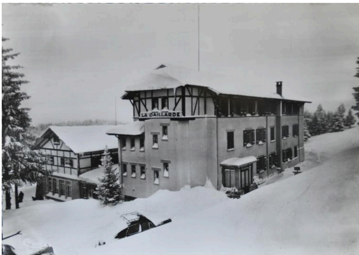
Pignon nord et façade donnant sur la route (ouest)
