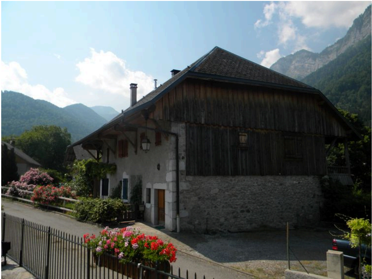
Vue de trois-quarts depuis le perron de l'église.
