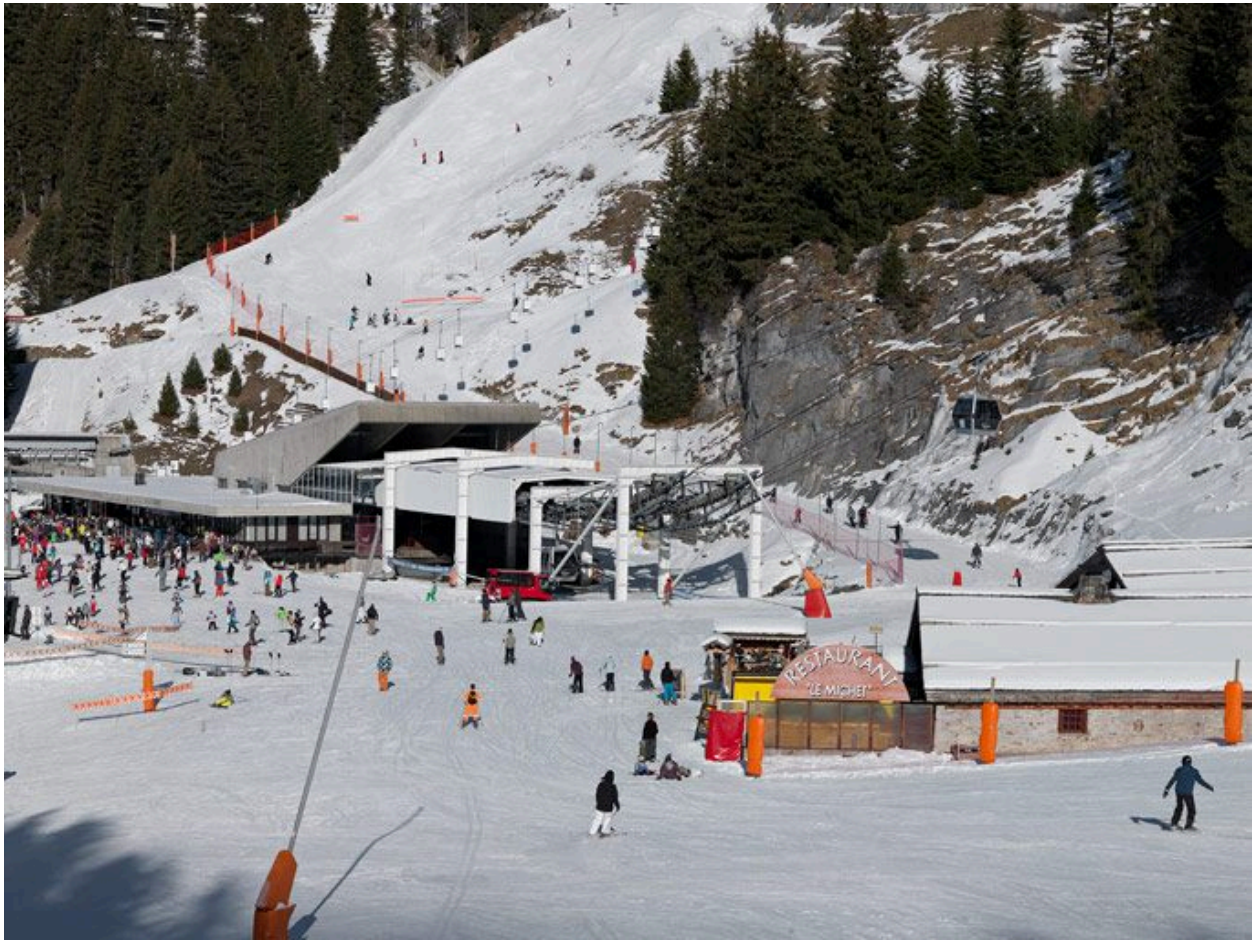
Vue depuis le sud-est
