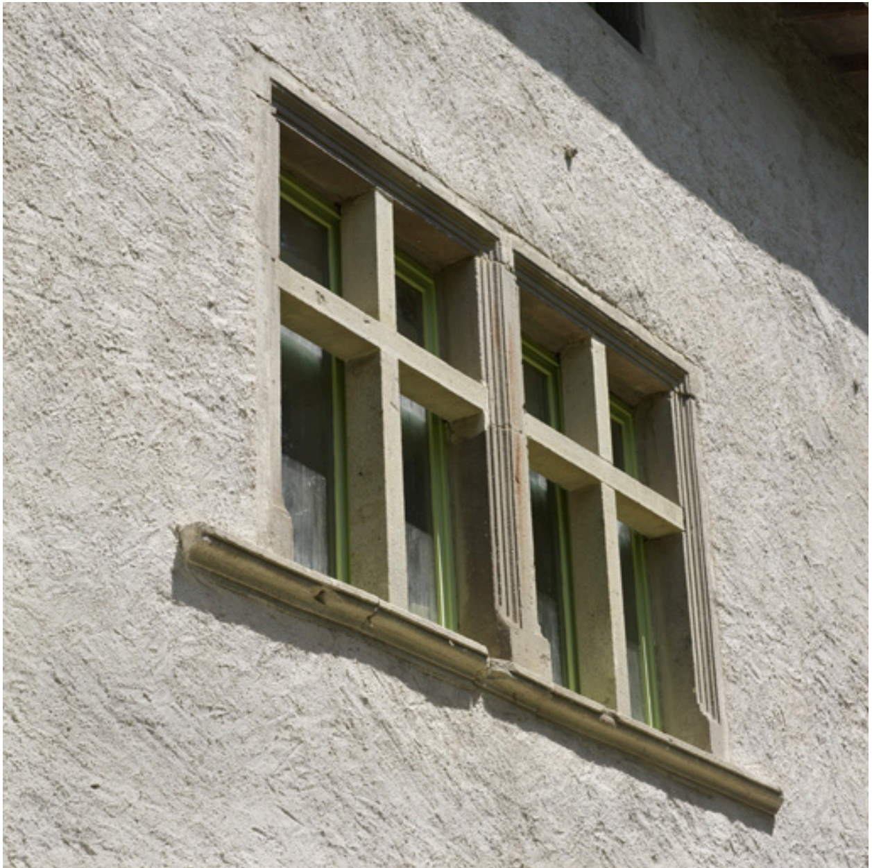
Détail de la fenêtre ouest du rez-de-chaussée surélevé de la façade sud.
