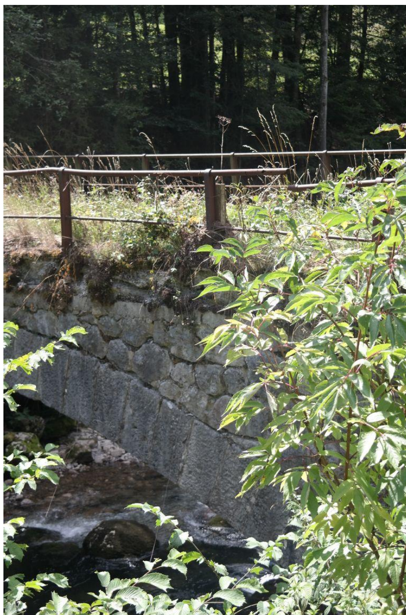
Pont des Portes ancien, détail tablier et garde-corps
