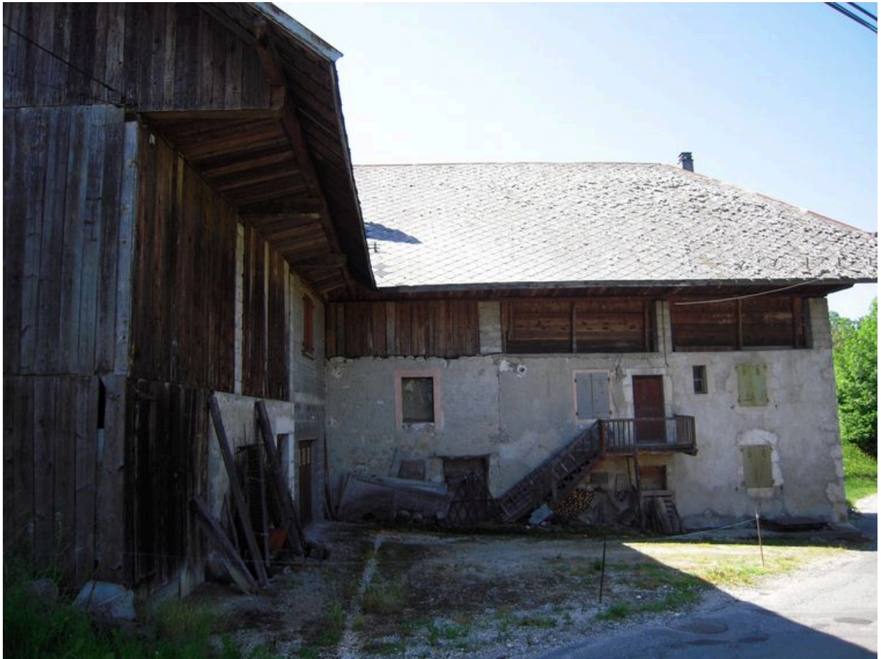
Vue de la façade nord.
