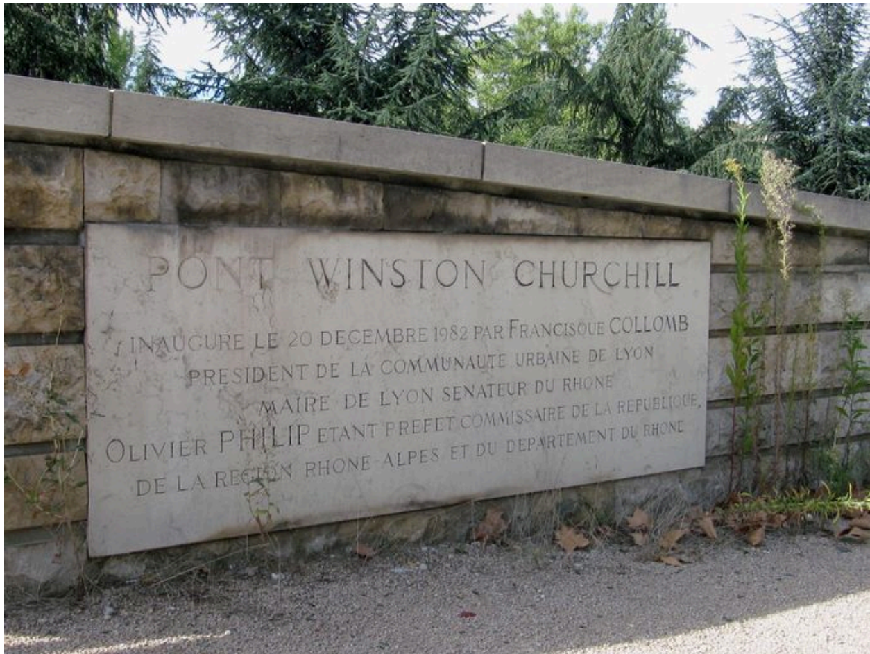
Parapet, vue de détail : inscription (depuis la rive gauche)
