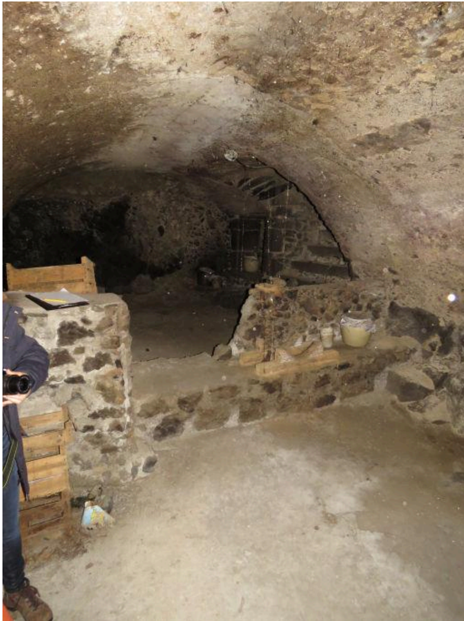
Vue intérieure : sous-sol
