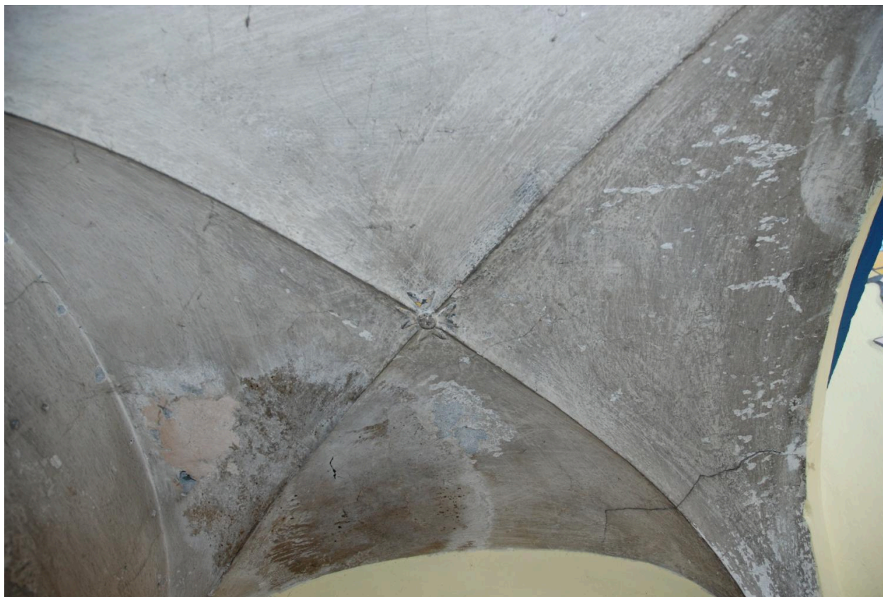
Vue intérieure de l'escalier en pierre : détail du voûtement avec décor de croix bifide.
