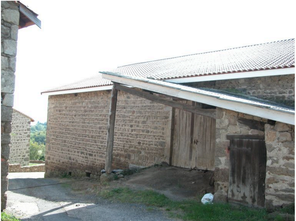
Vue d'ensemble de l'élévation nord de la grange-étable.
