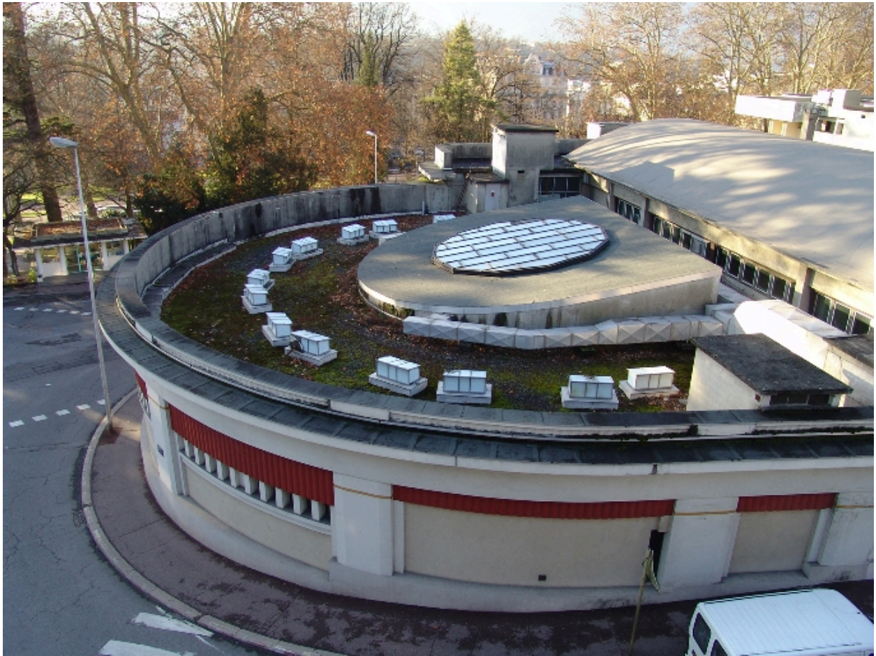
Terrasse en couverture
