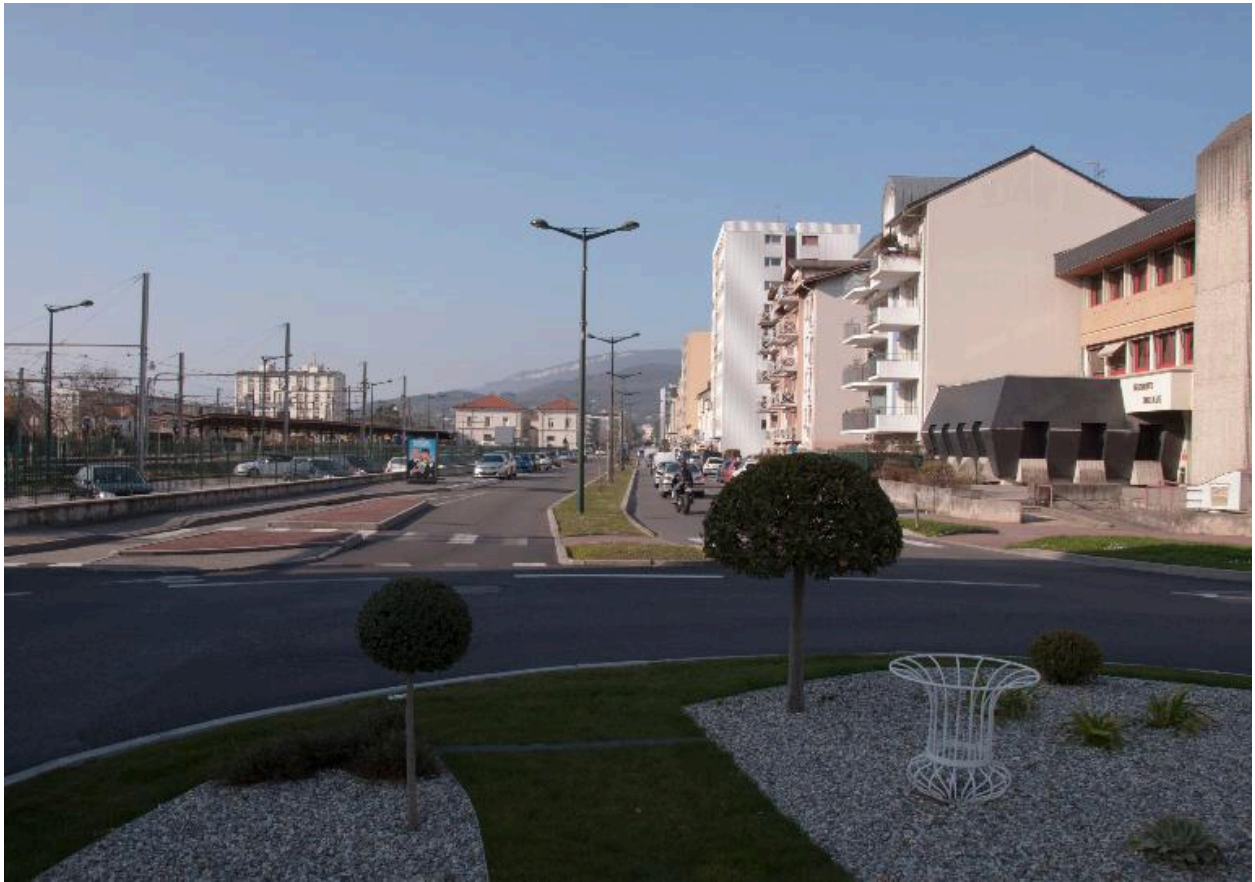
Vue depuis le sud en direction du nord
