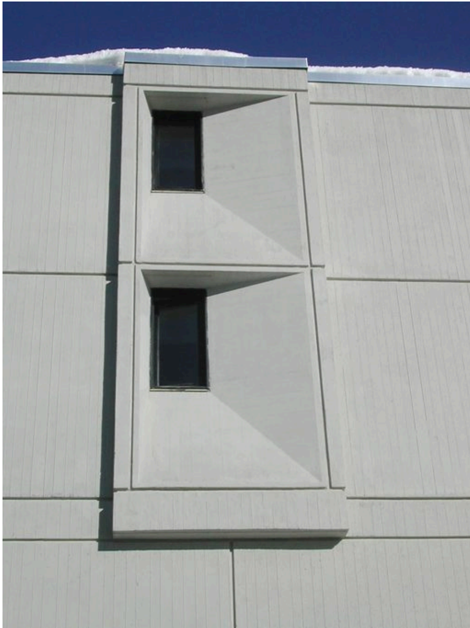
Détail des baies du pignon ouest
