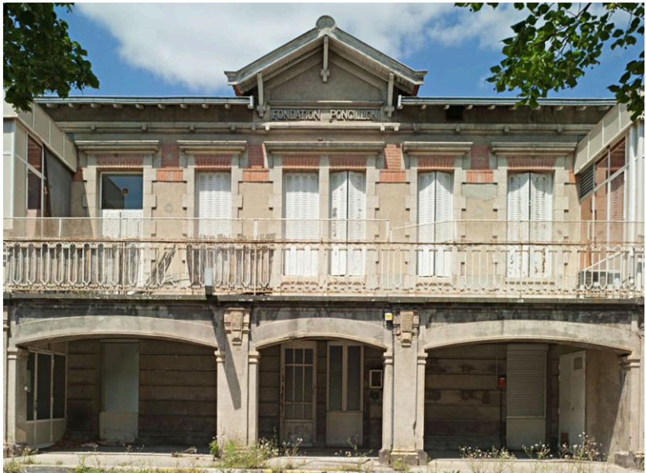
Hôtel-Dieu de Clermont-Ferrand. L'hôpital pour enfants, pavillon Gosselin, partie centrale de la façade principale vue du sud.
