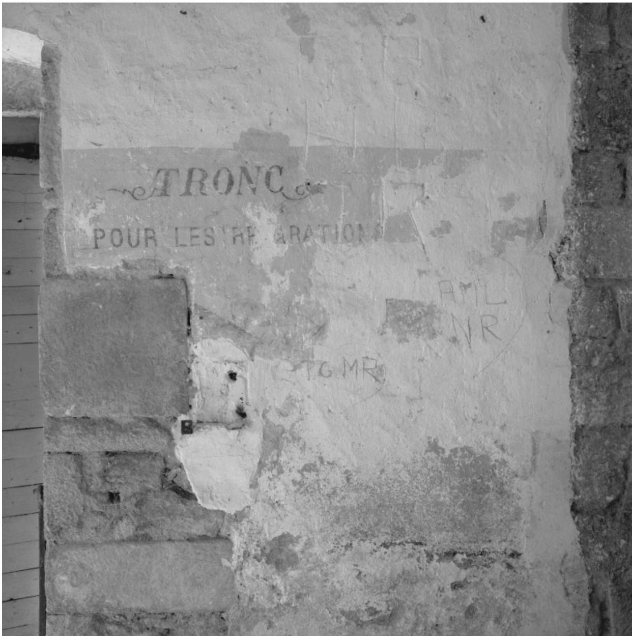
Vue de détail d'une inscription située sur le mur intérieur ouest : "tronc pour les réparations".
