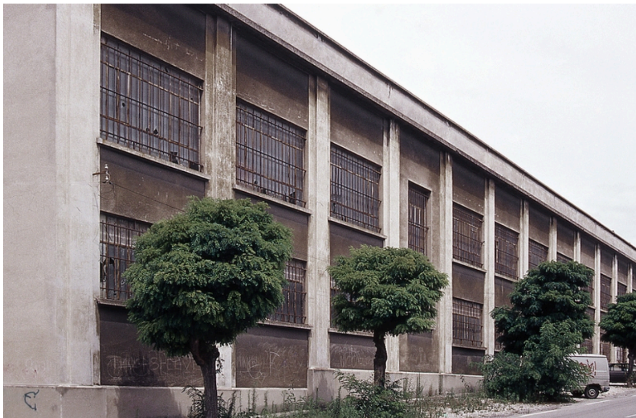
atelier localisé à l'entrée de la cartoucherie, vue nord
