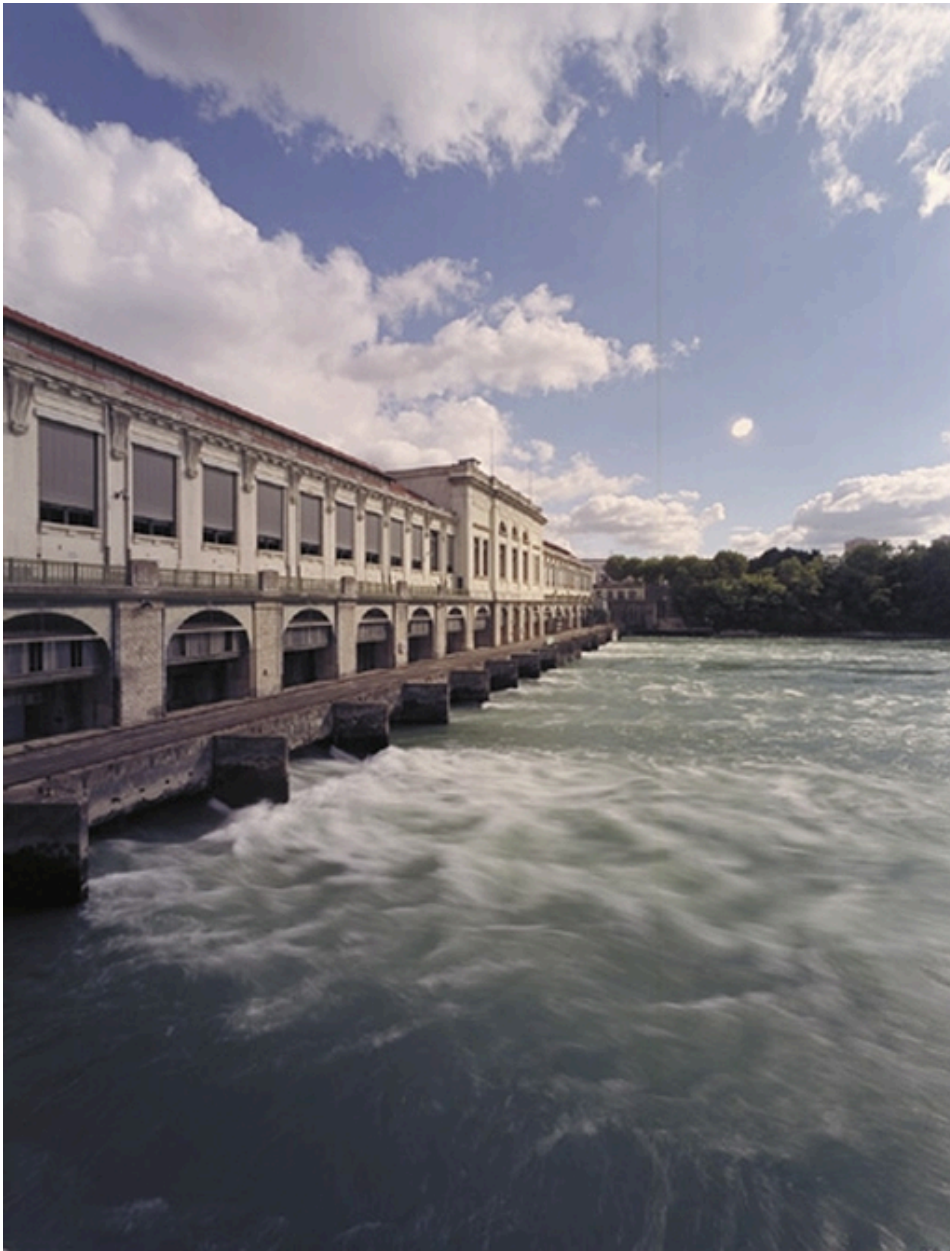
Vue sud-est façade aval, arrière-becs
