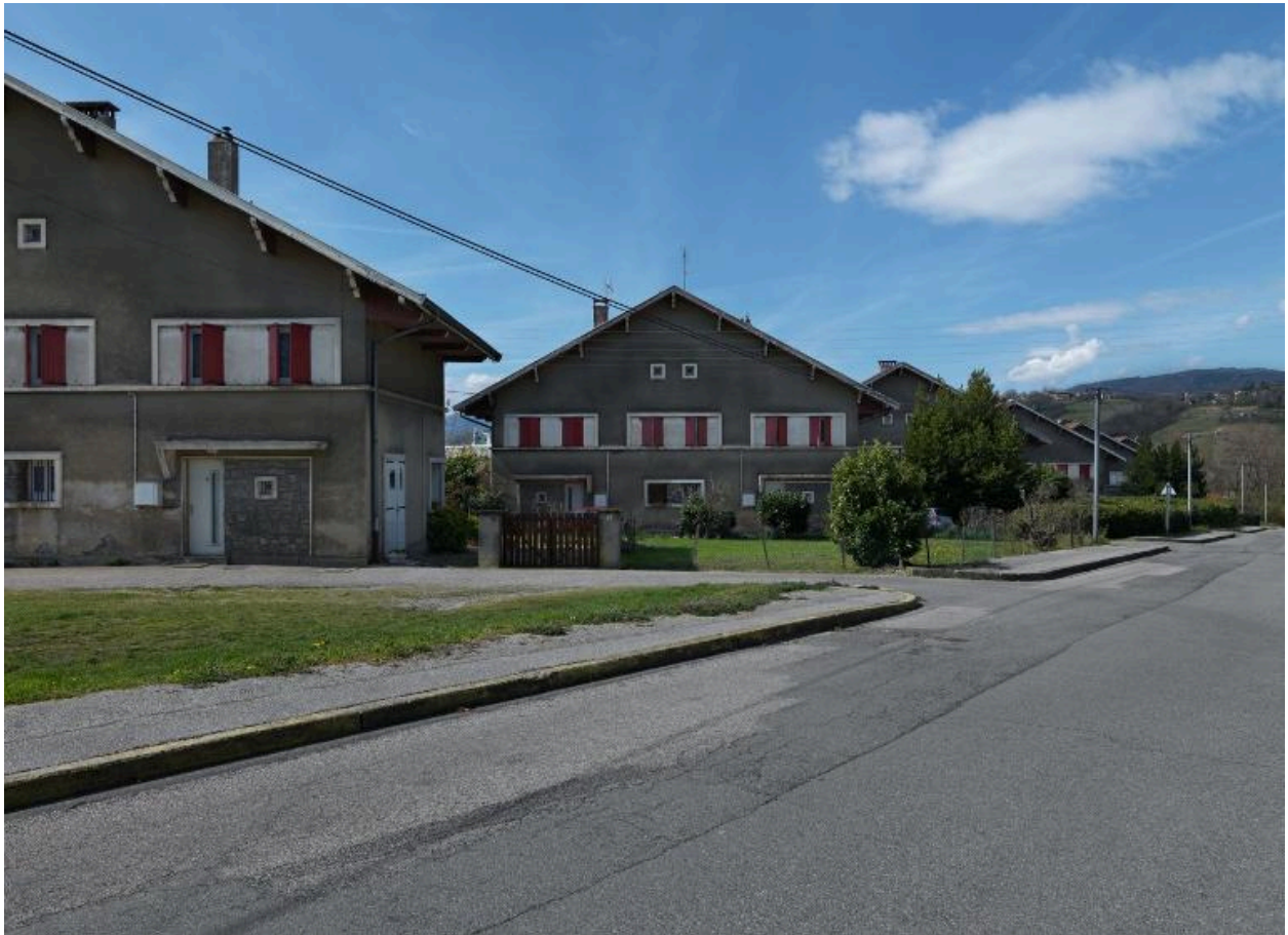
Maison ouvrière type chalet
