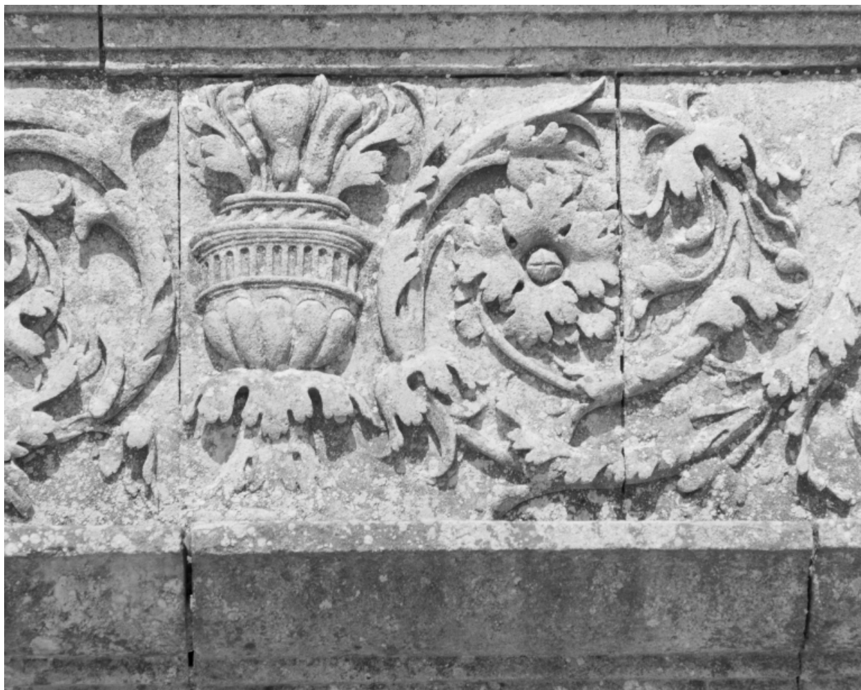
Cour du puits. Façade sud. Troisième travée de la frise sculptée de rinceaux.
