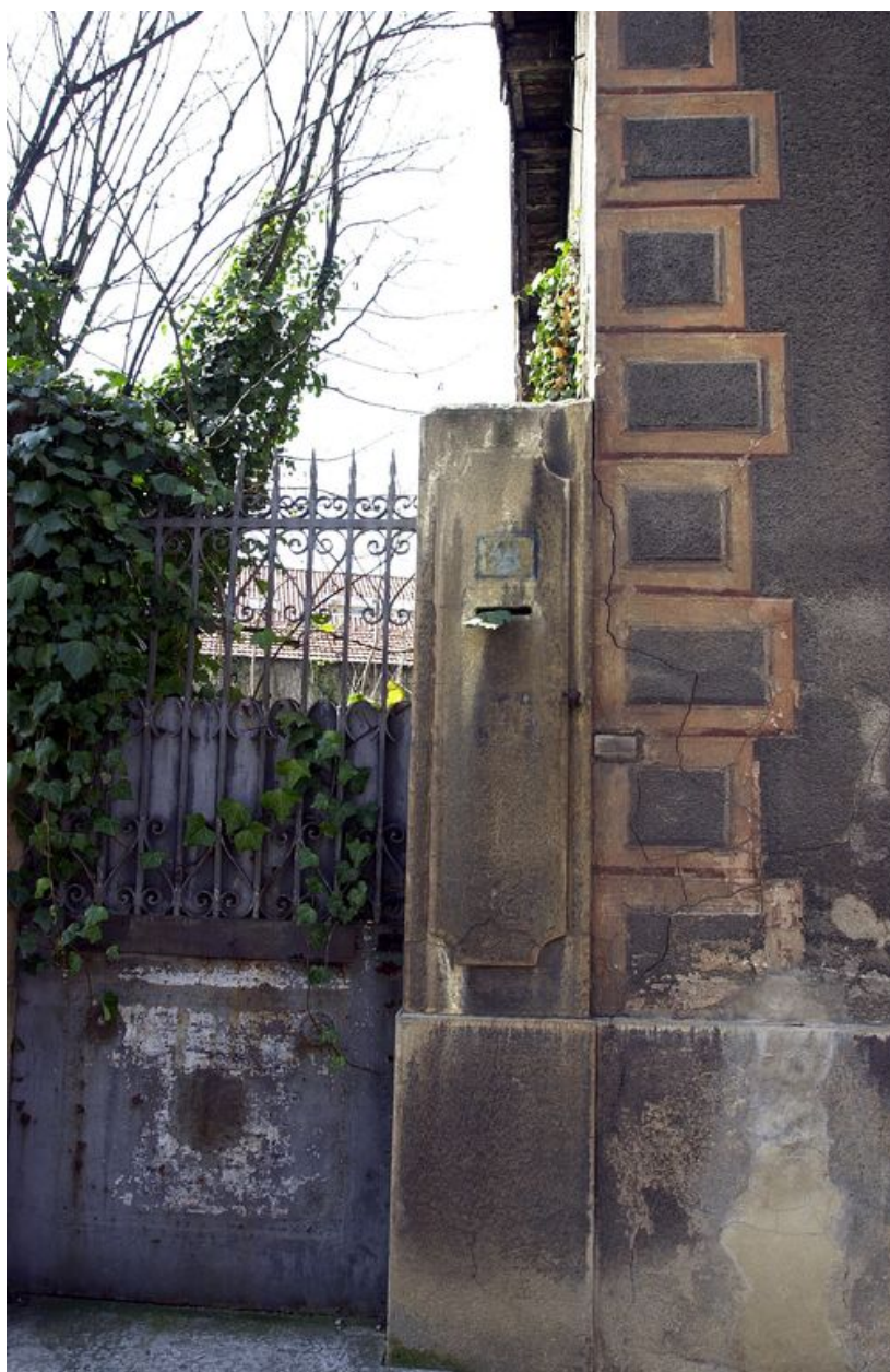
Entrée piétonne, boîte aux lettres encastrée dans le pilier de la porte et détail de l'enduit avec fausse chaîne d'angle harpée
