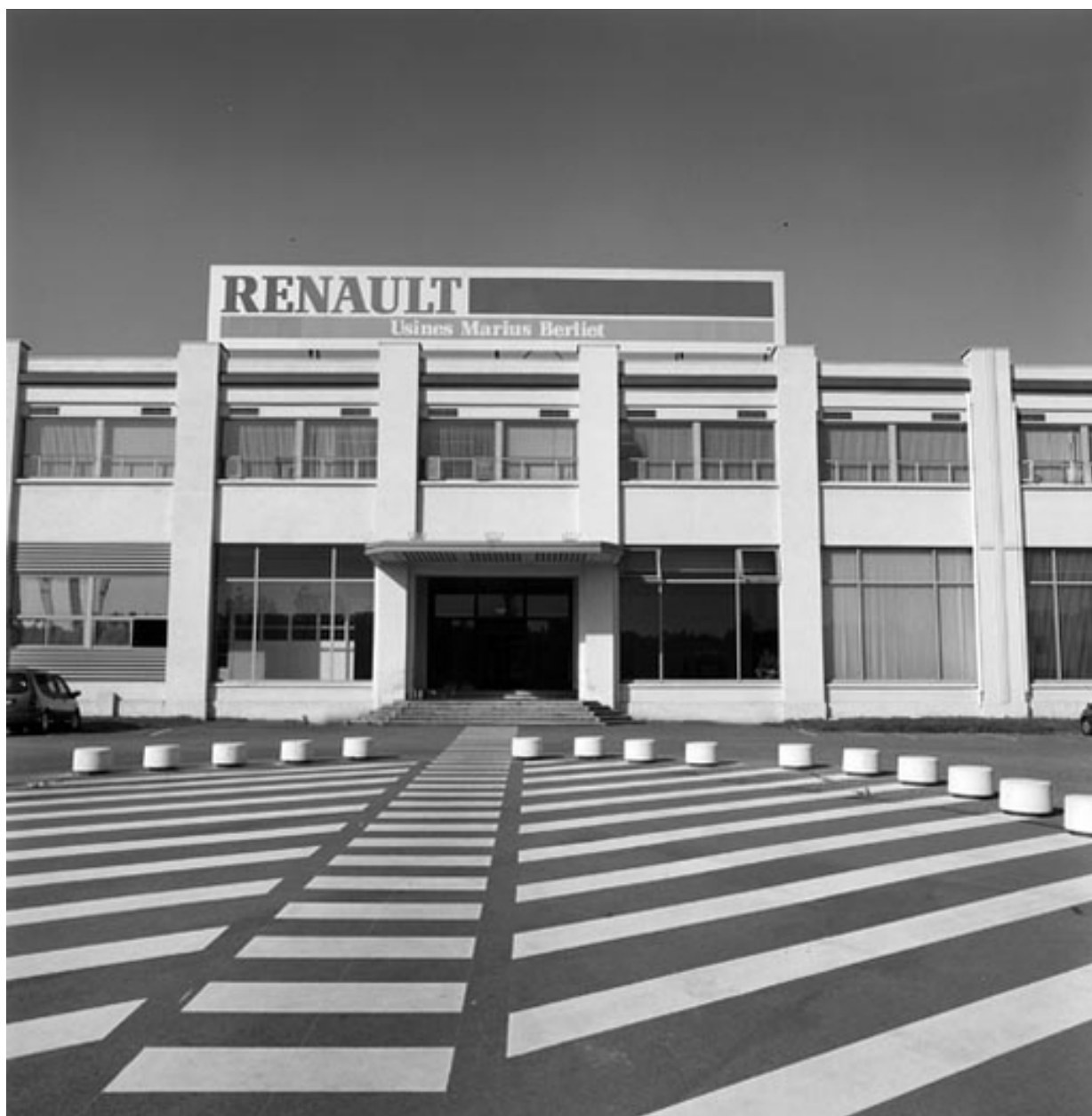
Détail entrée principale
