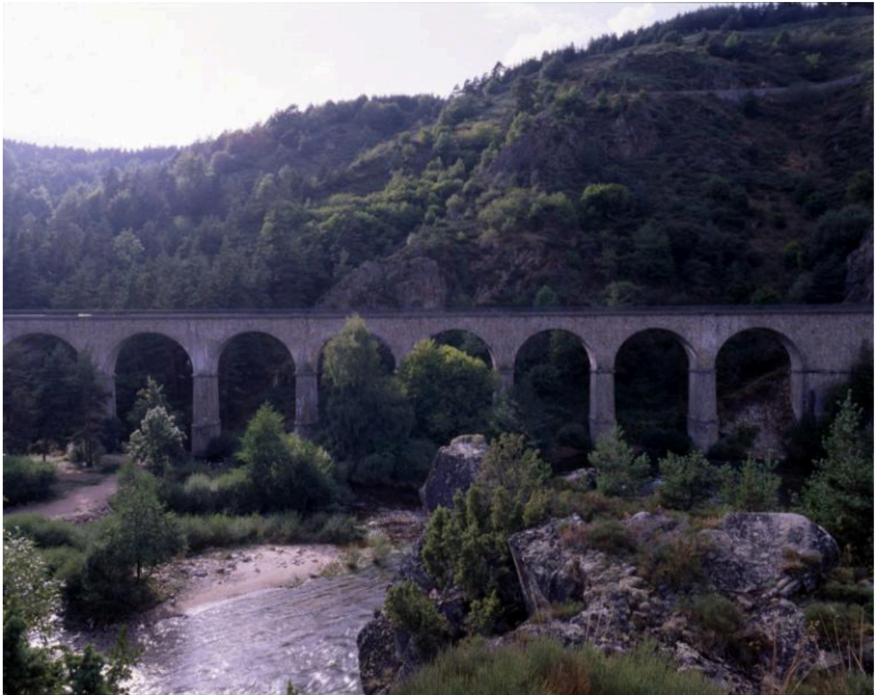
Détail du viaduc courbe de Chapeauroux.
