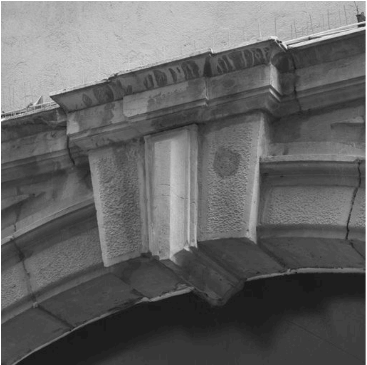
Façade sur rue, rez-de-chaussée, arcade boutiquière de gauche, détail de la clef
