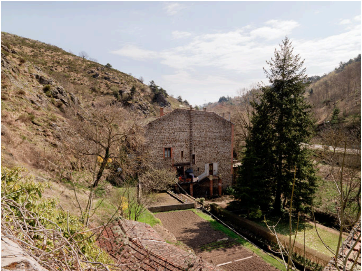
Vue du pignon de la partie habitation, depuis l'ouest.
