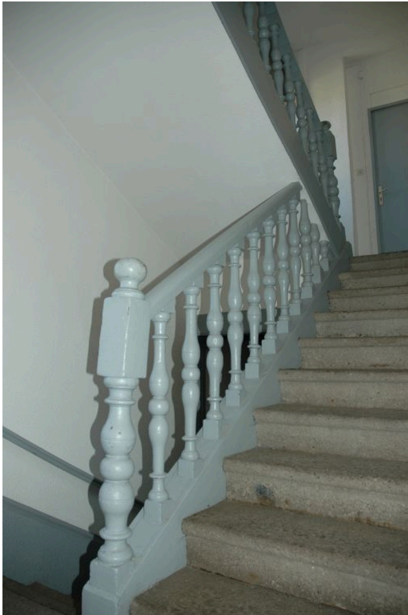
Montée d'escalier avec garde corps en bois tourné.
