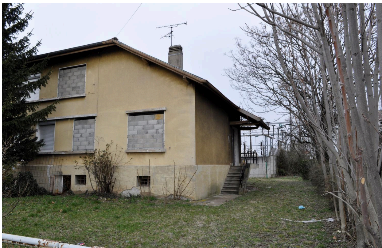
Vue d'extérieur, logements ouvriers, cité EDF
