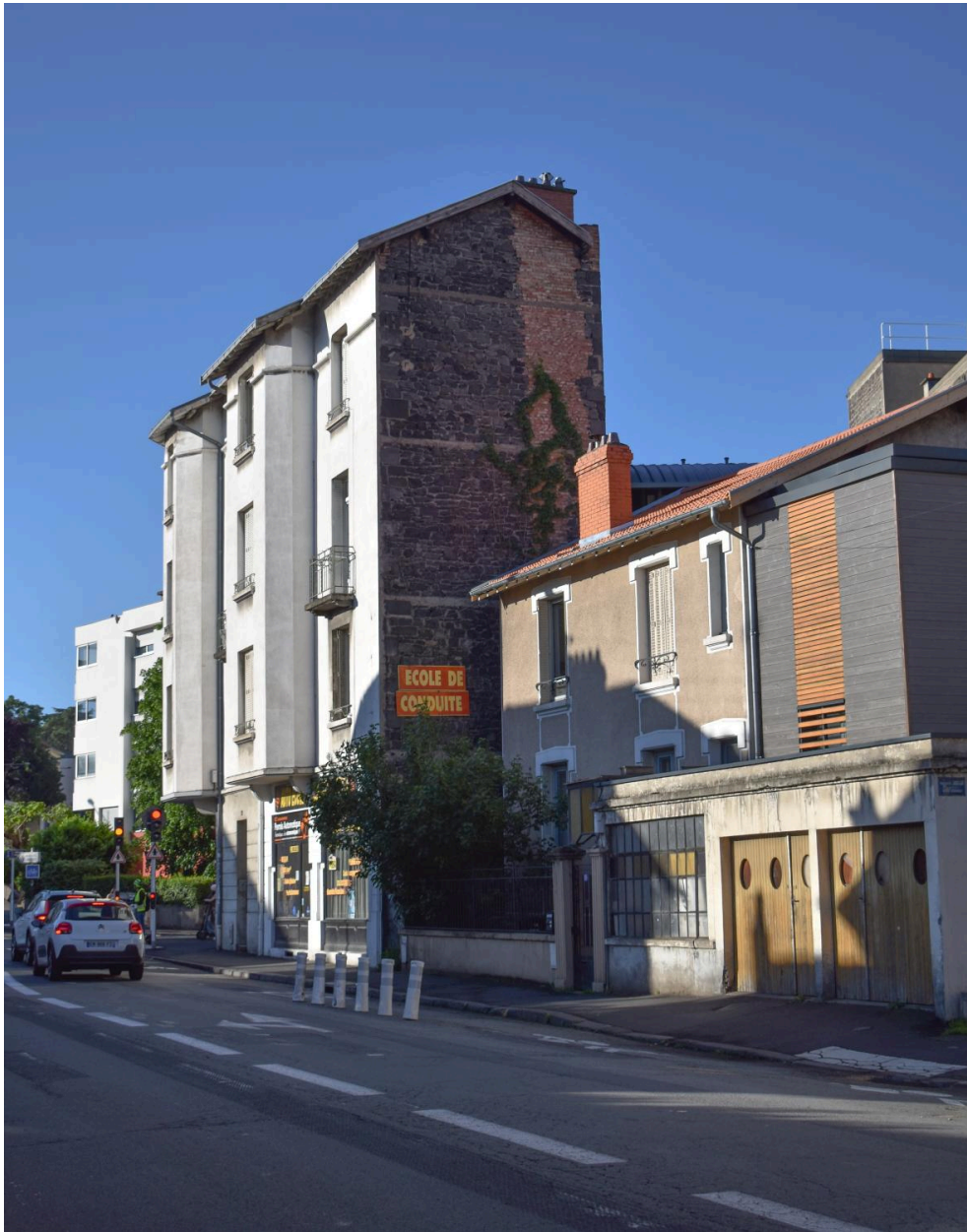
façade et mur d'héberge sur l'avenue Léon-Blum
