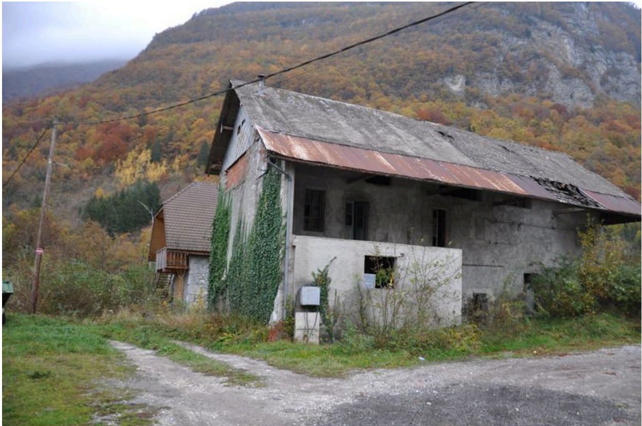
Vue de l'élévation nord-ouest de la scierie
