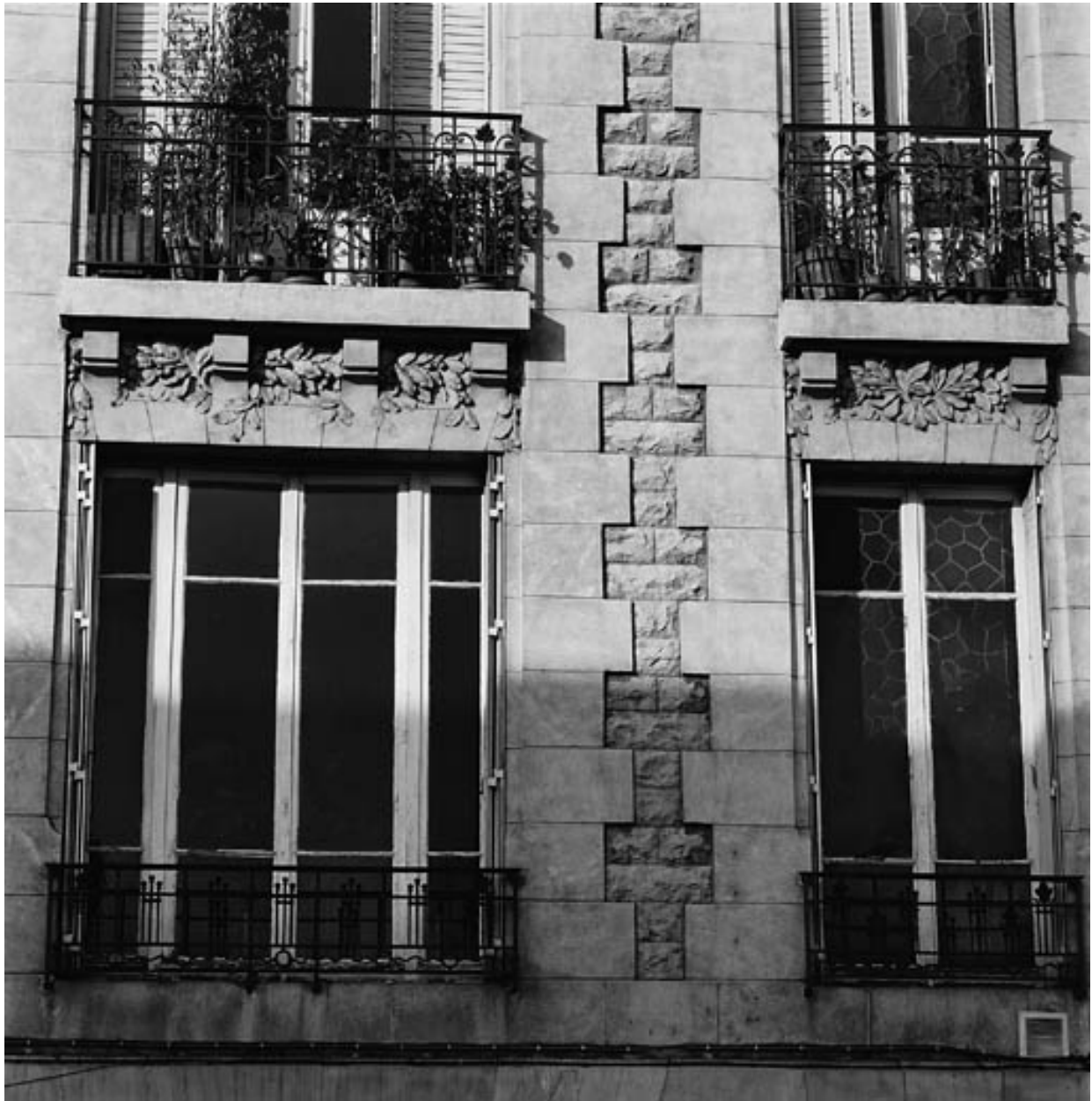
Détail des fenêtres : motifs sculptés et garde-corps en fonte
