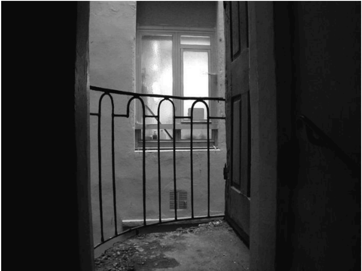
Passage reliant le 2e étage d'escalier aux lieux d'aisance
