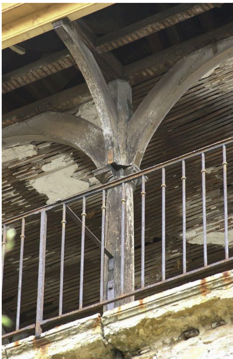
Détail d'une colonne en bois supportant la toiture
