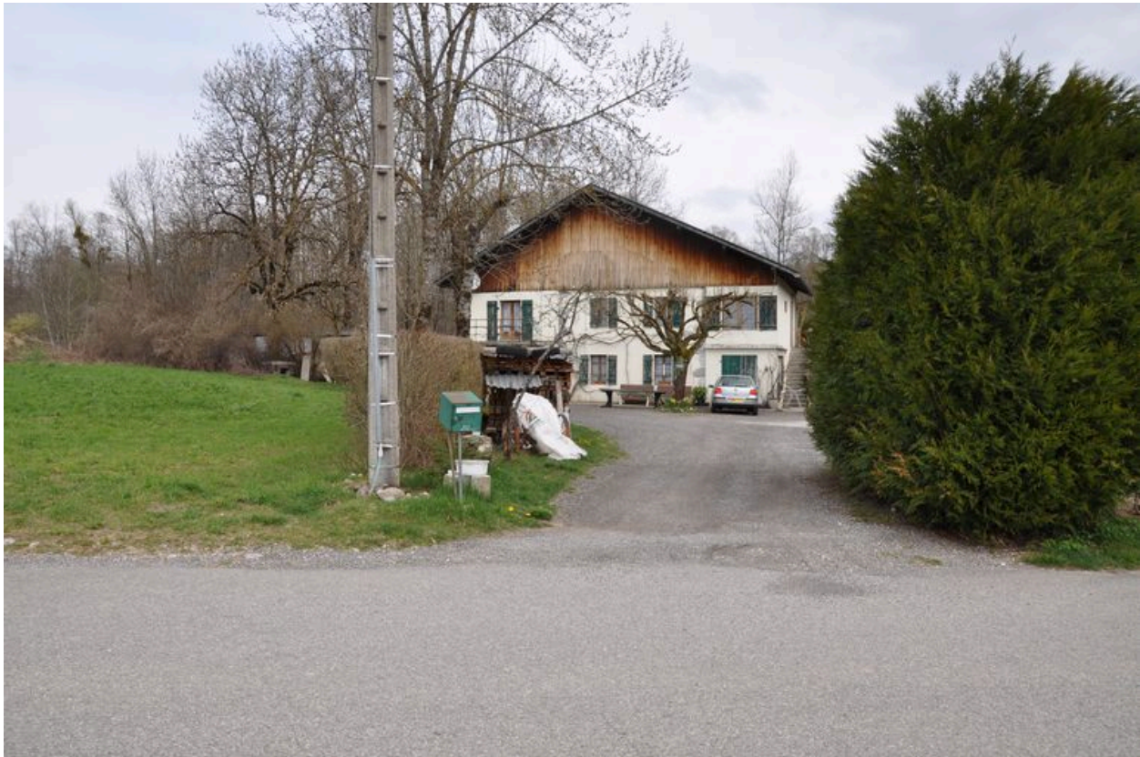
Façade antérieure remaniée de l'ancien bâtiment du moulin
