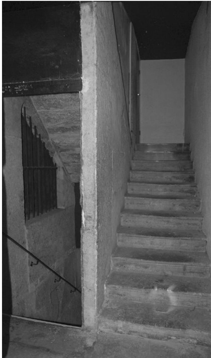
1ère volée de l'escalier rampe sur rampe
