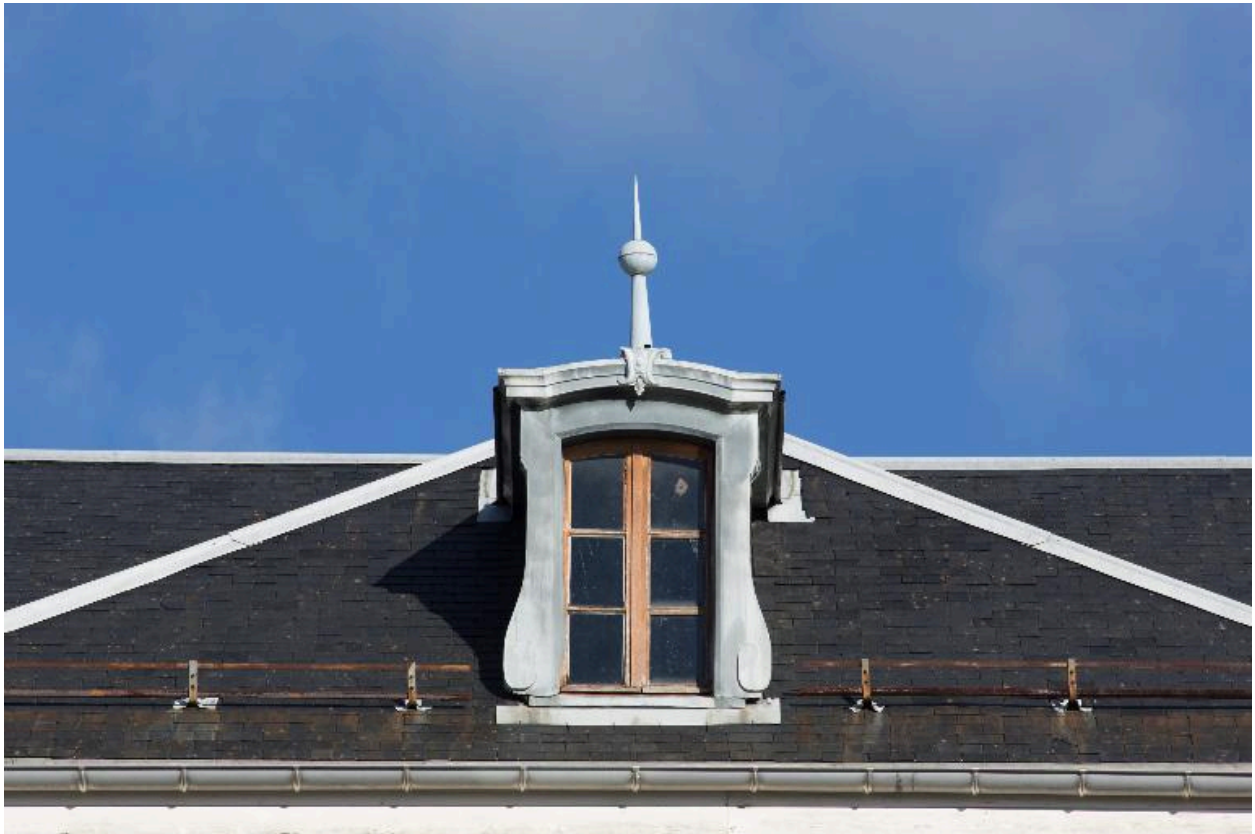
Cour 2 : lucarne sur pente de versant du bâtiment est.
