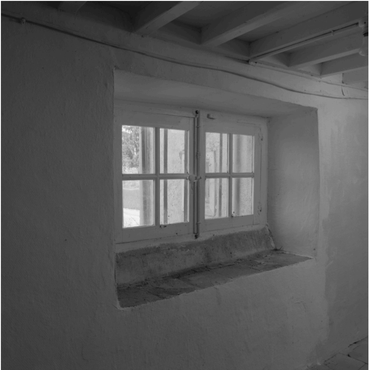
Vue intérieure, entresol de la maison, chambre située à l'ouest : détail de la fenêtre.
