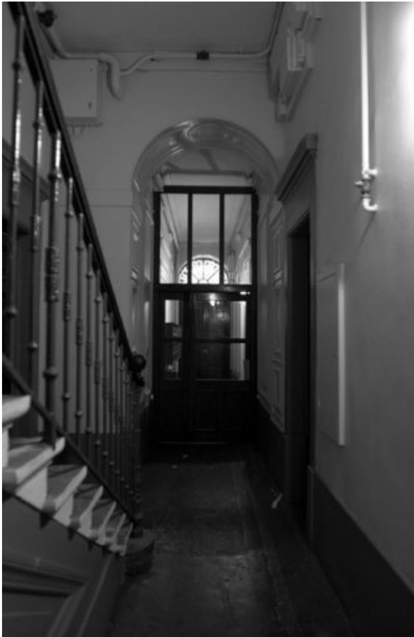
Bâtiment 1, allée vue depuis l'escalier
