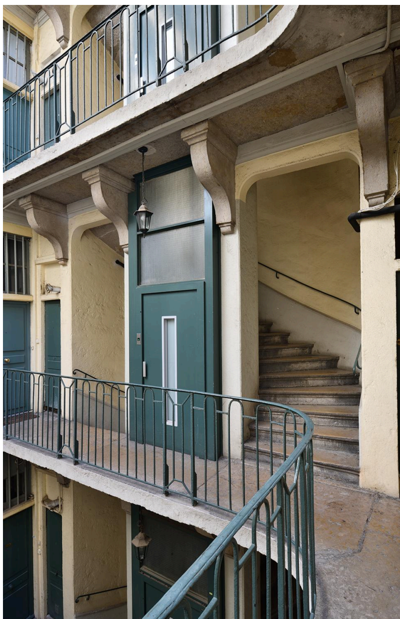
La cour : galeries et volée d'escalier
