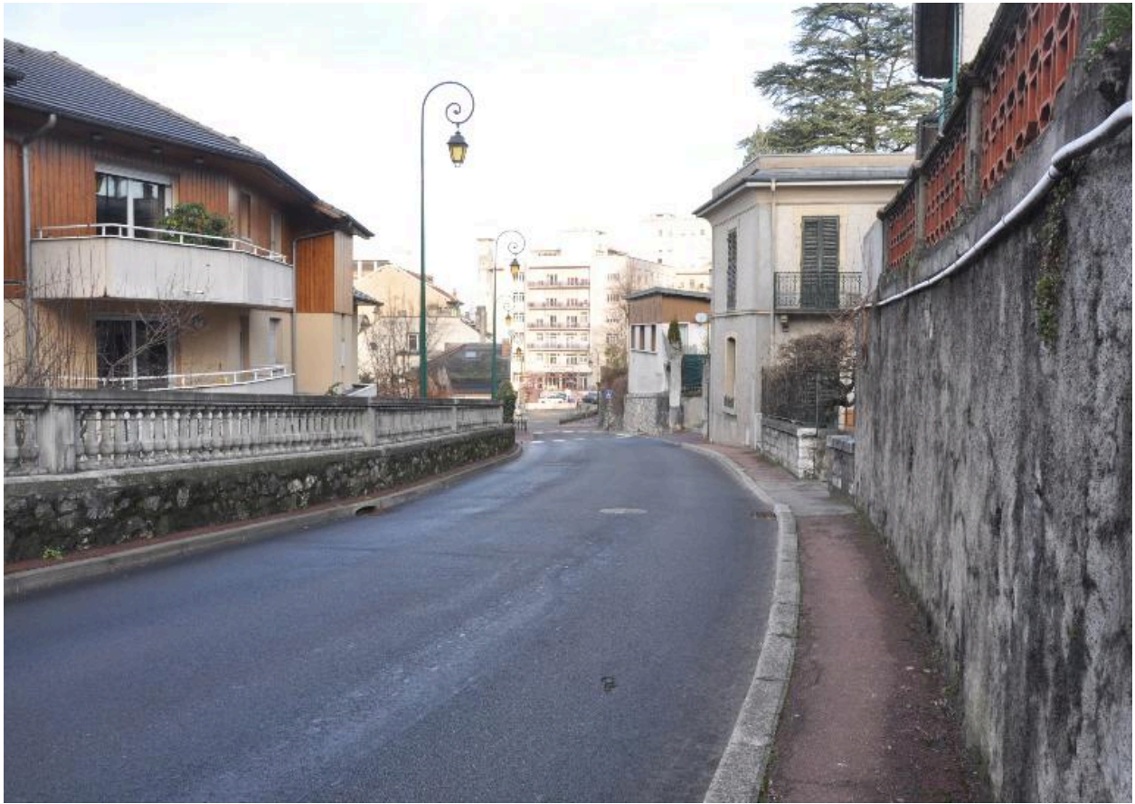
Vue vers le nord, au fond l'hôpital Reine-Hortense
